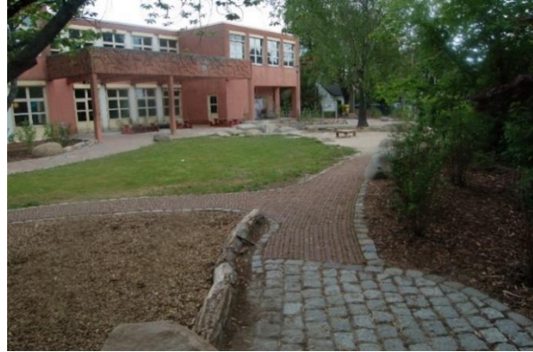
Abbildung 19: Kita- und Hortgebäude Wildhüterweg, Foto: QM Gropiusstadt, S.T.E.R.N. GmbH, 2020.
