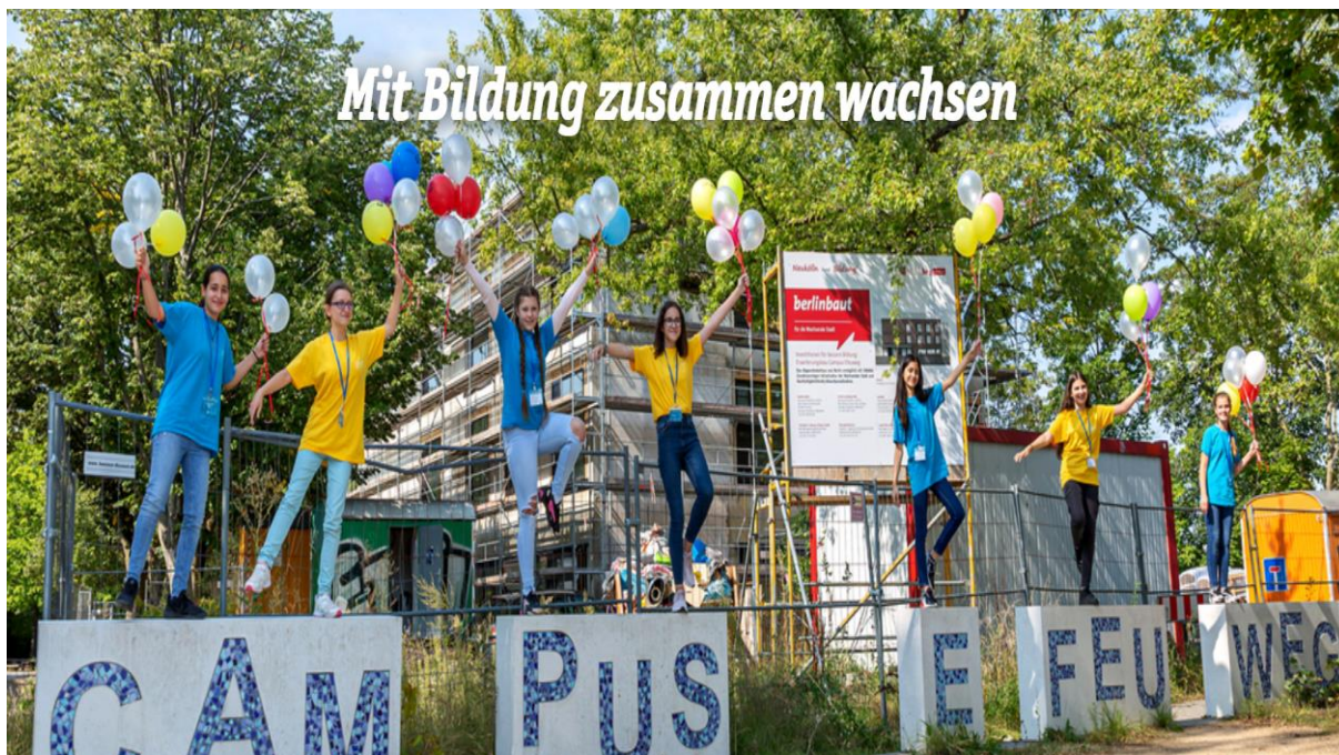
Abbildung 16: Eingangsbereich Campus Efeuweg, dahinter die im Bau befindliche Bibliothek, Foto: BA Neukölln/Sinisa Wagner.
